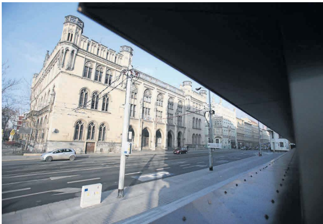
Gwardia Wrocław po ponad 70 latach musi wyprowadzić się z Krupniczej. Oficjalnie ze względu na zły stan techniczny budynku
