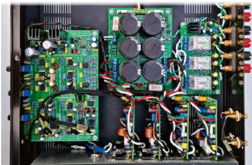
Fotografia 15. Zbliżenie ukazujące szczegóły kompletnego okablowania sygnałowego oraz niskonapięciowego zasilania DC
