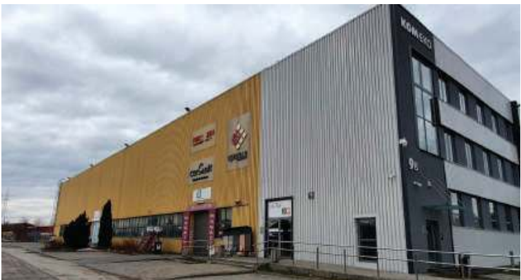
Na sortowni Ekopak stanie jedna z największych dachowych instalacji fotowoltaicznych w Polsce
