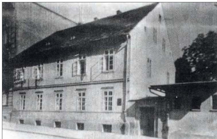
Na fotografiach przemiany budynku dzisiejszego przedszkola
