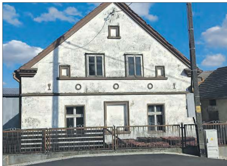
Elewacja ołtarzowa w Nowym Dworze Prudnickim
