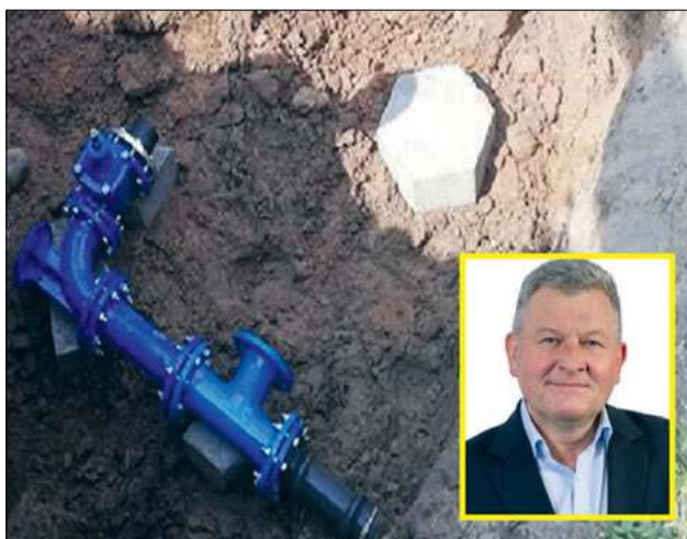
– W ramach projektu zostanie wykonana modernizacja ujęć wody w Tucznazoraz Wólce Zabłockiej – informuje wójt Zygmunt Litwiniuk
