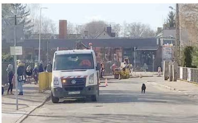
Prace wykonane były już jakiś czas temu na ul. Stefana Żeromskiego, pomimo tego, że droga powiatowa czeka na całościową przebudowę jeszcze w tym roku
