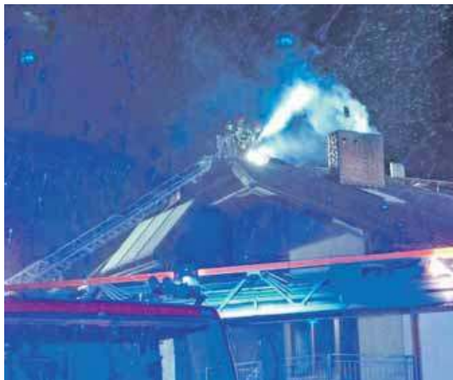
Zarzewie ognia zlokalizowano w kalenicy więźby dachowej, pod warstwą izolacji z wełny mineralnej
