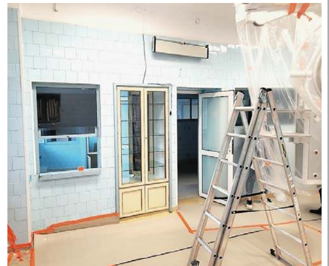
W szpitalu trwa remont bloku operacyjnego
