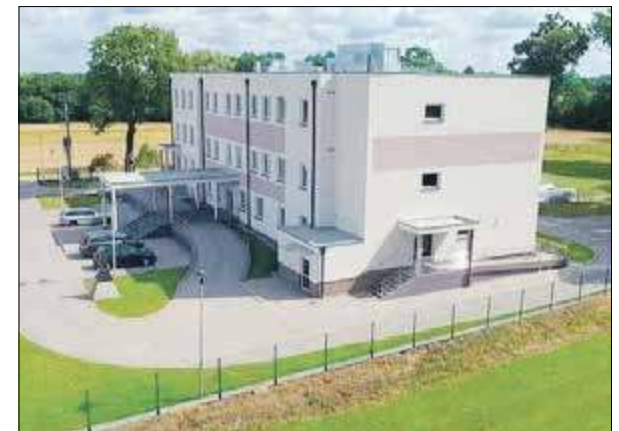
Budynek po dawnej szkole został przebudowany i przystosowany do potrzeb pacjentów
