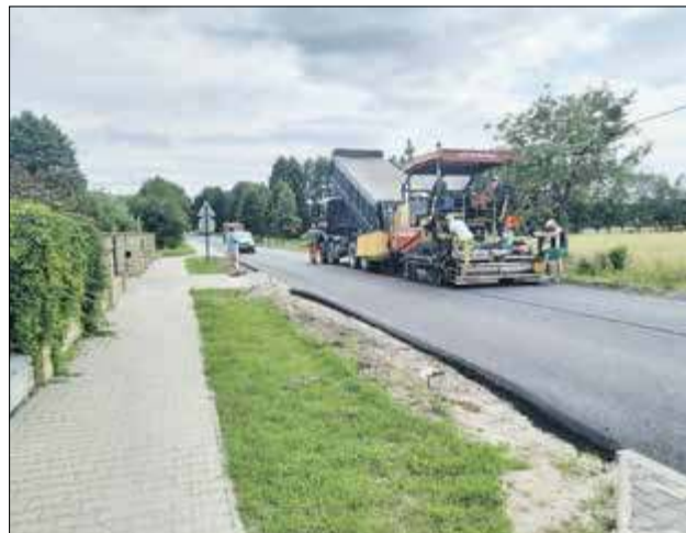
Obecnie trwają również zaawansowane prace na kilometrowym odcinku drogi od Piszczacu Kolonii w kierunku Tucznaj. Dodatkowo w Piszczacu Kolonii na odcinku 850 m zostanie wybudowana ścieżka rowerowa
