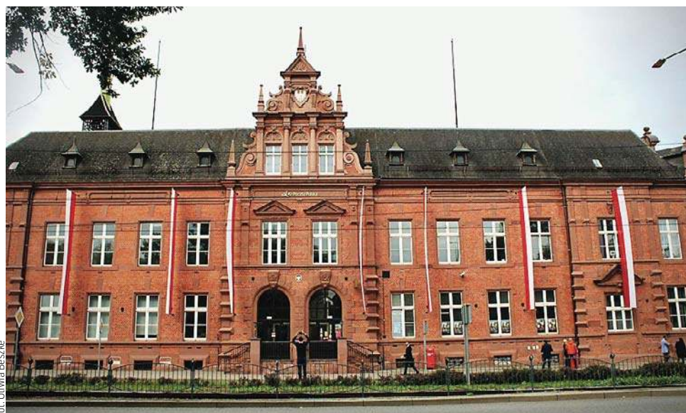
W środę uroczystość zakończono trwający osiem lat remont elewacji zabytkowego gmachu poczty
