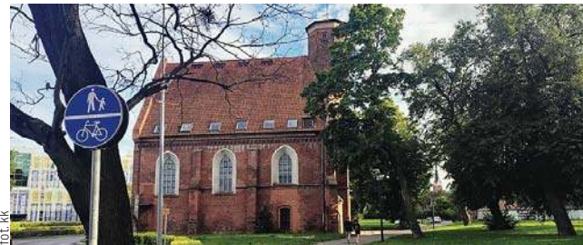
W ramach drugiej edycji Rządowego Programu Odbudowy Zabytków dofinansowanie na restaurację i renowację zabytkowych murów otrzymał między innymi kościół p.w. Bożego Ciała w Elblągu
