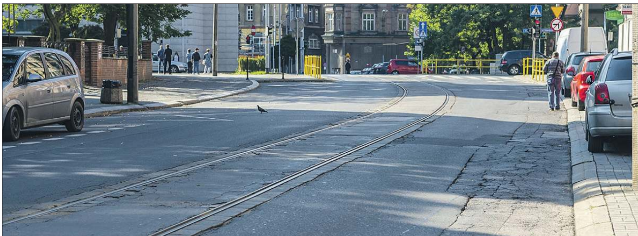
Ulica Piekarska wreszcie doczeka się przebudowy
