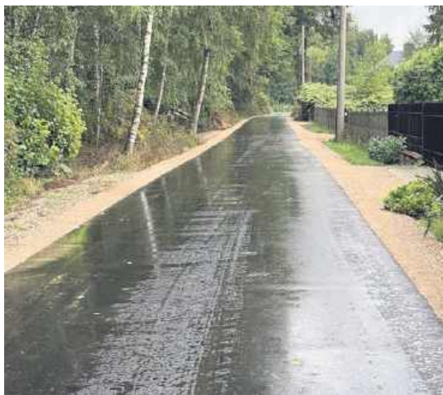
Wybudowany odcinek drogi w Kamiennej Woli
