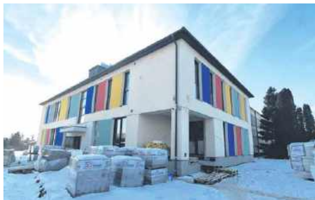
Obiekt żłobka w trakcie prac.
