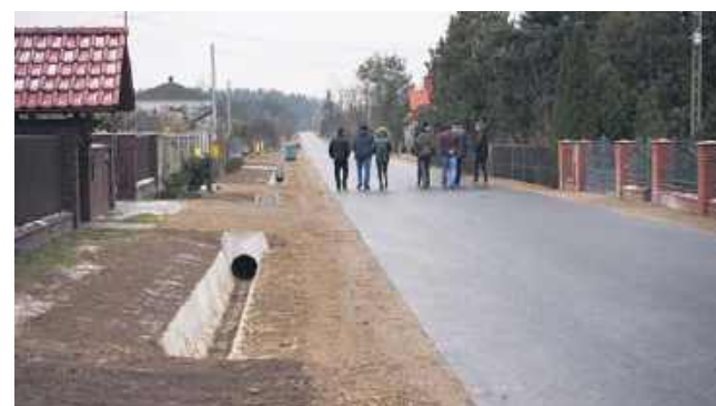
Przebudowana droga w m. Ruda
