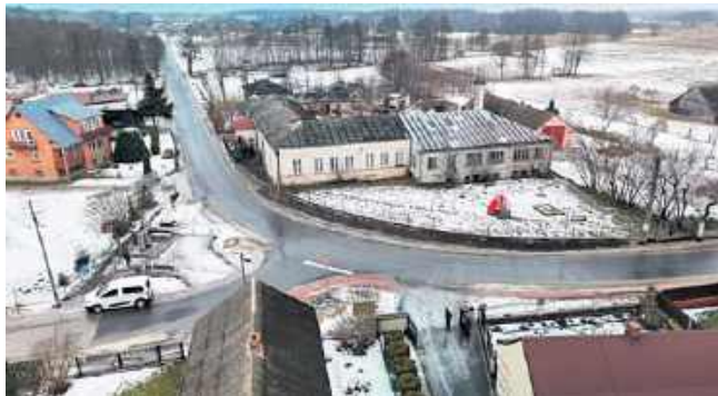
Przebudowana droga powiatowa 4506W Zwoleń – Sarnów w m. Sarnów
