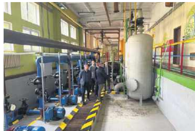
Złazki w Białobrzegach do modernizacji
