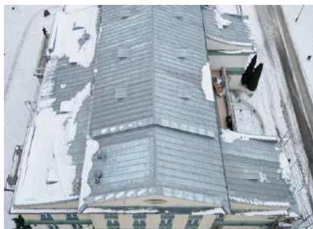
Wymieniony dach budynku Miejskiego Ośrodka Kultury w Pionkach przy ul. Zakładowej 5
