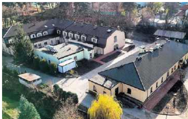
Pawilon nr 3 Domu Pomocy Społecznej po przebudowie
