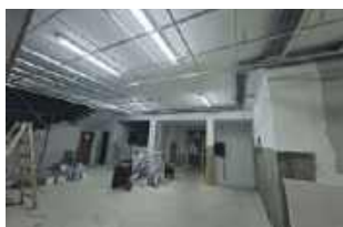
Początki remontu w Urzędzie Gminy w Wierzbicy
