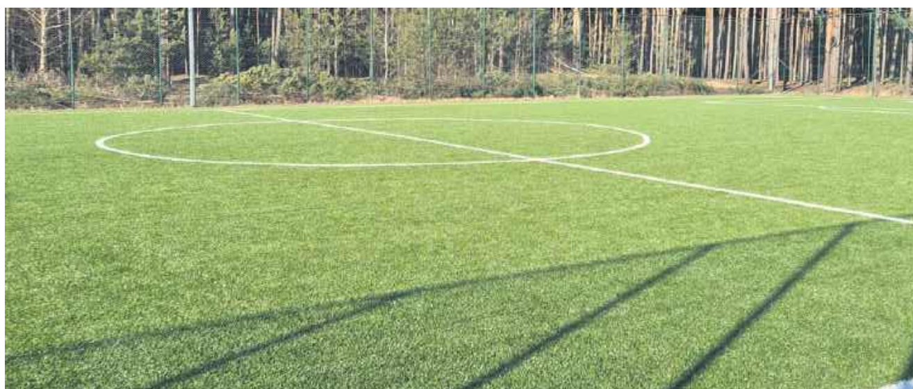
Orlik w Wyśmierzycach po wymianie nawierzchni.
