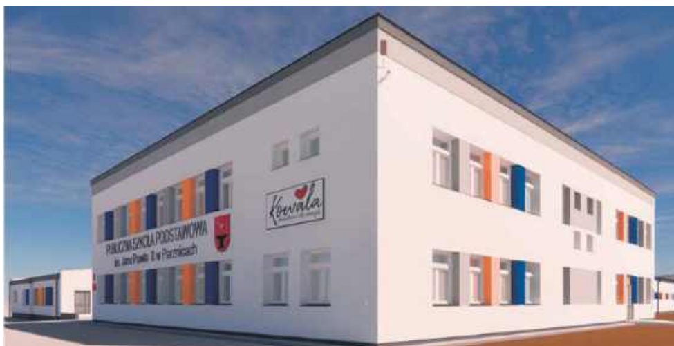
Projekt PSP w Parznicach po termomodernizacji
