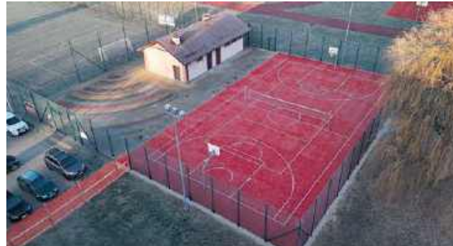
Zmodernizowane boisko przy Zespole Szkół Nr 1
