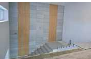
Remont UG w Wierzbicy - schody
