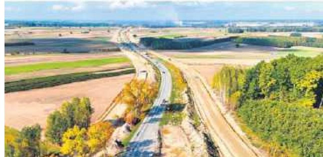
Budowa obwodnicy Ciepiałowa
