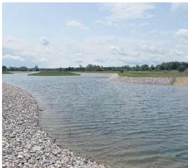
Wybudowany zbiornik retencyjny „Wysokin” w miejscowości Ceteń
