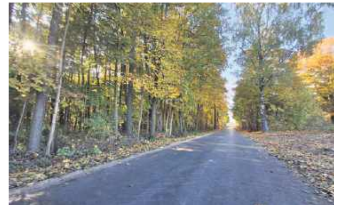
W październiku oddano do użytku przebudowany odcinek drogi gminnej w Sosnowicy.
