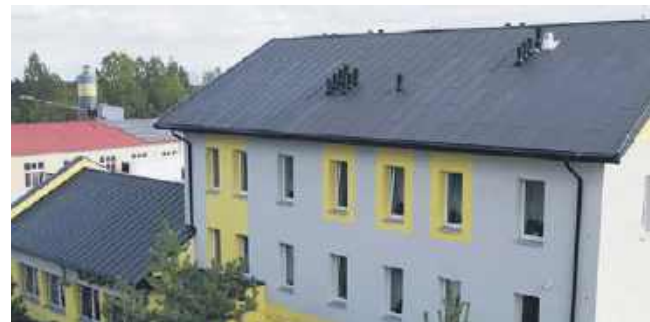
Dach fotowoltaiczny na budynku ZPRS w Goździkowie
