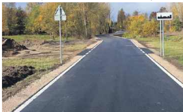
Przebudowa drogi gminnej
