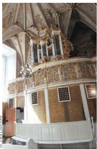
Projekt obejmuje też renowację organów w kaplicy zamkowej
