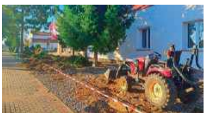
Prace przed budynkiem urzędu
