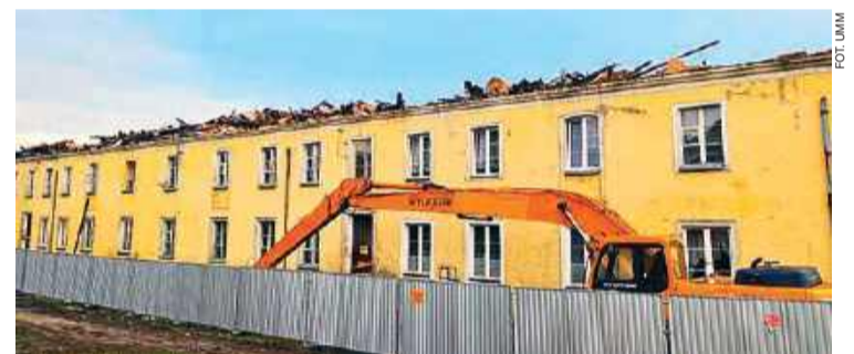
Budynek będzie rozebrany do poziomu fundamentów
