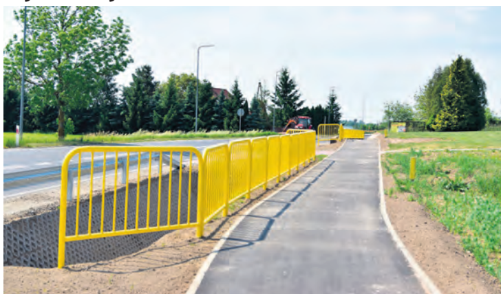
Na zdjęciu fragment ścieżki pieszo-rowerowej z wykonaną nawierzchnią bitumiczną.
