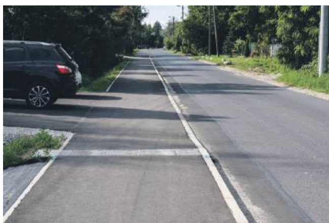
Tak wygląda wyremontowany fragment ul. Chrobrego
