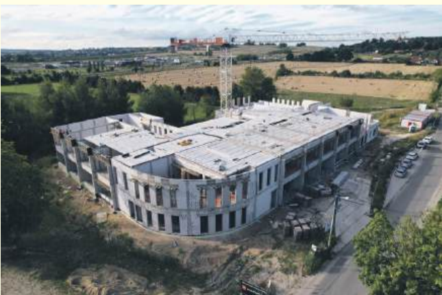
Obecnie trwa murowanie ścian piętra
