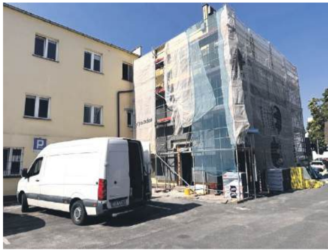
Trwa remont biurowca
