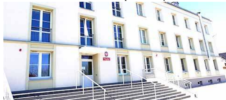
W Bursie Szkolnej wyremontowane zostaną łazienki oraz kuchnia
