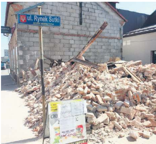
Rozebrany niedawno budynek nie był użytkowany od kilkunastu lat. Groził zawaleniem.
