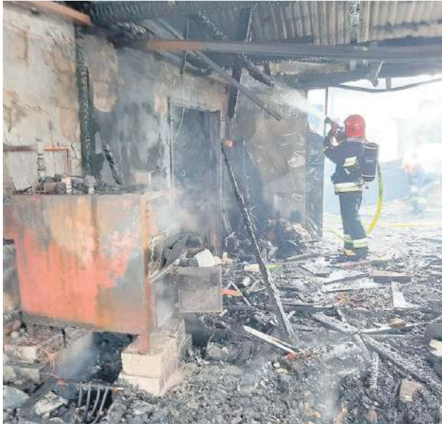
Strażacy wstępnie określili, że pożar rozpoczął się od pieca w garażu, a jako prawdopodobną jego przyczynę wskazali nieszczelny przewód kominowy.
