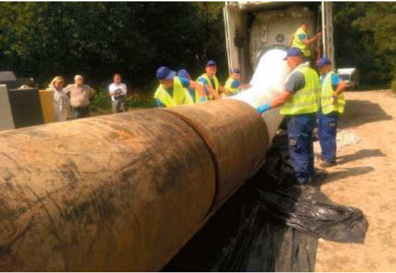
Naprawa rurociągu metodą rękawa termoutwardzalnego sprawdziła się w Krakowie
