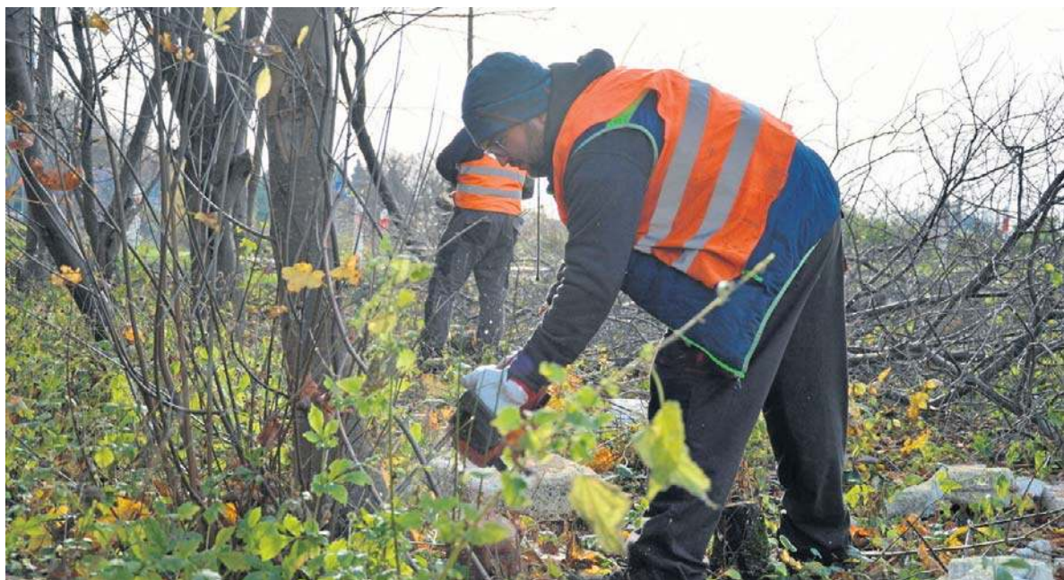
Trwają prace porządkowe na nieczynnej linii kolejowej nr 256. Szlak ma być odbudowany
