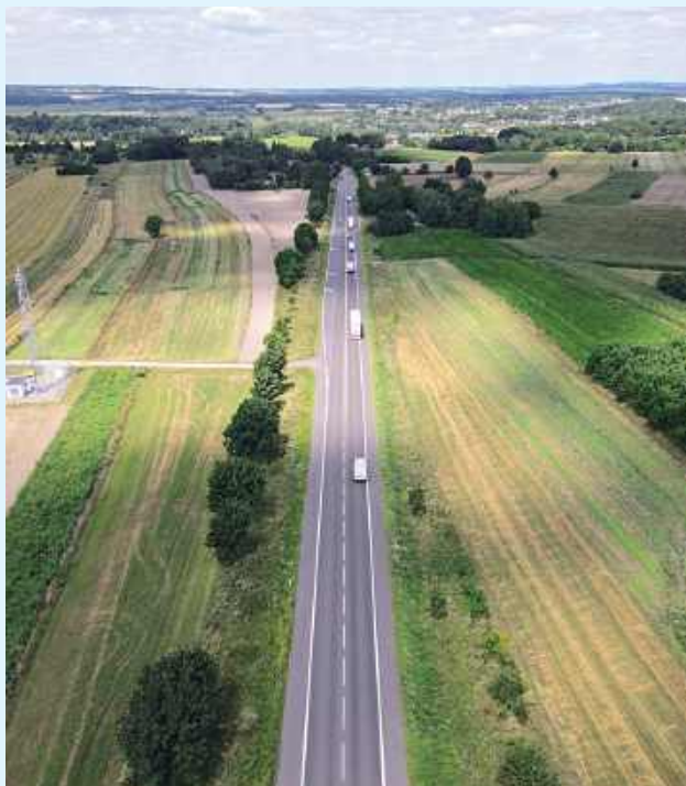
Kolejny odcinek drogi ekspresowej S17 prowadzi przez gminy Krasnystaw, Izbica oraz Stary Zamość
