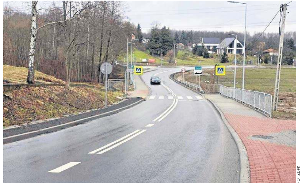
Dwie drogi powiatowe w Gaju, Lusinie i Libertowie w gminie Mogilany zostały przebudowane za prawie 45 mln zł
