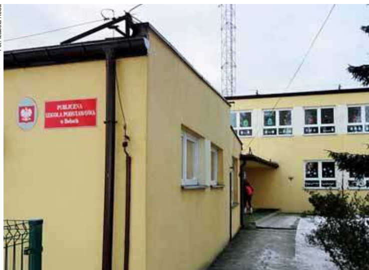
Do filii w Bobach (tu budynek przed termomodernizacją i przekształceniem szkoły) uczęszcza tylko 4 dzieci z klas I-III i 5 z oddziału „0”
