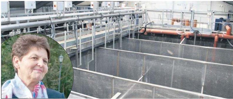
Urszula Kolman: Powstaje obecnie wiele domków turystycznych. Można się domyślać, że każdy właściciel takiego obiektu zechce, aby podłączyć go do oczyszczalni ścieków.
