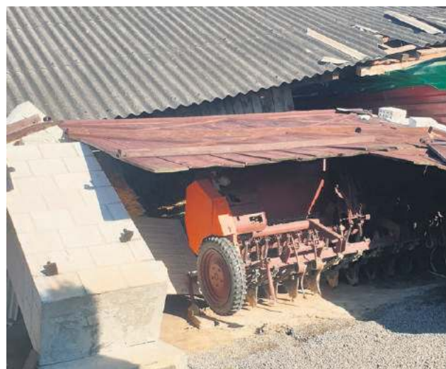
W wyniku nawałnicy zawalił się budynek gospodarczy w Bukowinie I.
