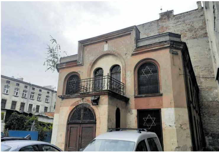
• Synagoga Reicherów w Łodzi FOT. PAWEŁ RUTKIEWICZ
