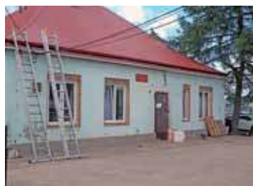
Trwa termomodernizacja budynków Urzędu Gminy i GOPS-u
