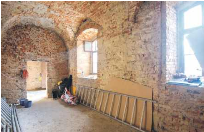
Ze ścian zakrystii skuto stare tynki
