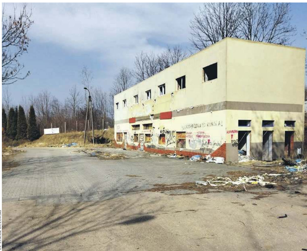
Na sprzedaż została wystawiona działka na terenie dawnej bazy PKS przy Balińskiej w Chrzanowie, gdzie m.in. funkcjonowała stacja paliw
