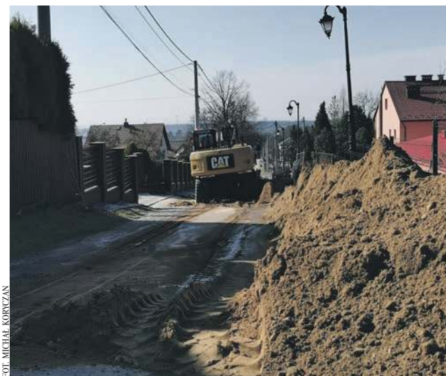
Budowa kanalizacji na ul. Zamkowej w Babicach
