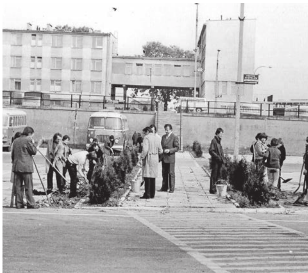
(ŁD) Biurowiec na chrzanowskiej zajezdni PKS w latach 80. XX w.
