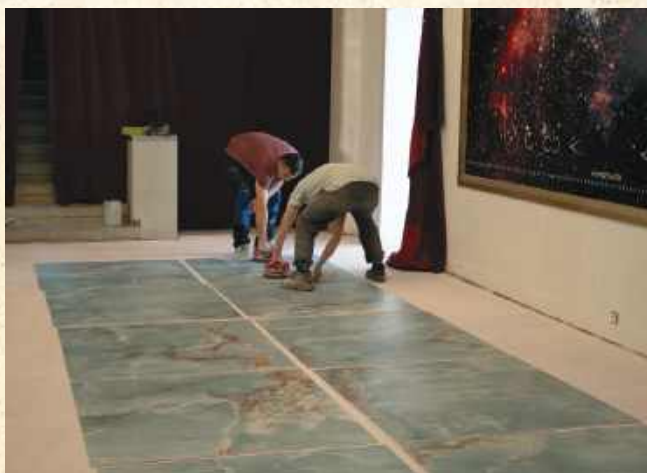
■ Remont pałacu wciąż trwa. Choć najtrudniejsze prace konstrukcyjne są już za właścicielami, w kolejnych pomieszczeniach nadal prowadzone są prace wykończeniowe. Do zakończenia całego przedsięwzięcia pozostało jeszcze sporo pracy.
