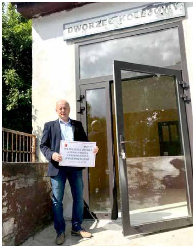
Gmina Chociwel przejęła już budynek poczekalni na dworcu kolejowym. Teraz można ruszać z pracami remontowymi
