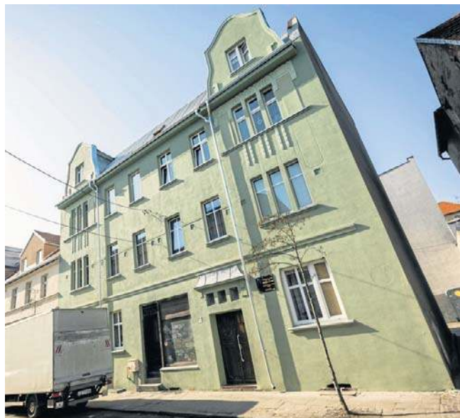
Budynek przy Jasnej 23 został odświeżony - na zielono
