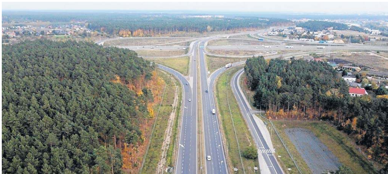
11 firm chciałoby zbudować 19,5 km S10 z Nakła nad Notecią do węzła Bydgoszcz Zachód (na zdjęciu)
