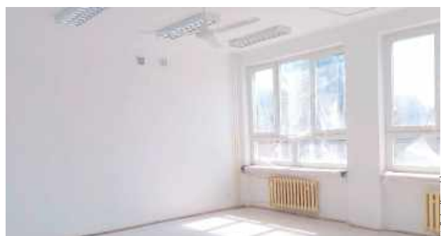
Jedna z sal oddziału przedszkolnego w Zespole Szkół w Karczmiskach podczas remontu. Pomieszczenie zyska nową wykładzinę, odświeżone ściany i sufity, oświetlenie oraz zmodernizowaną instalację elektryczną i sieć LAN
