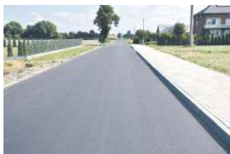
Przebudowana droga gminna w Fajstówkach
