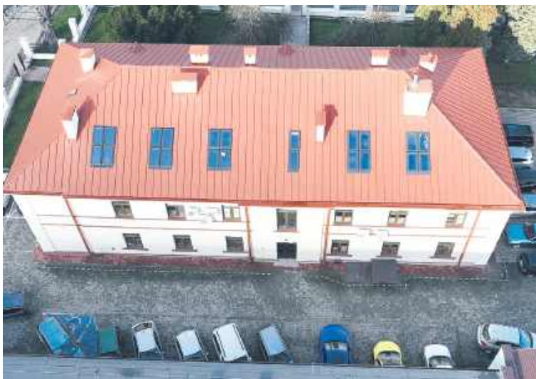
Remont dachu budynku Powiatowego Urzędu Pracy w Krasnymstawie
