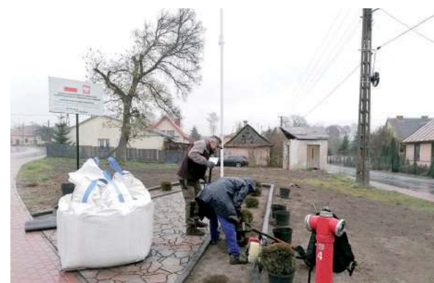
Chodel. Gmina zdecydowała się na zagospodarowanie terenu wokół masztu. Firma brukarska wykonała chodnik, a pracownicy Zakładu Gospodarki Komunalnej posadzili 11 tui wokół chodnika
