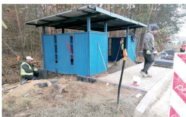
Ekipę brukarską zastaliśmy w minionym tygodniu podczas wykonywania prac na przystanku w Lipinach
