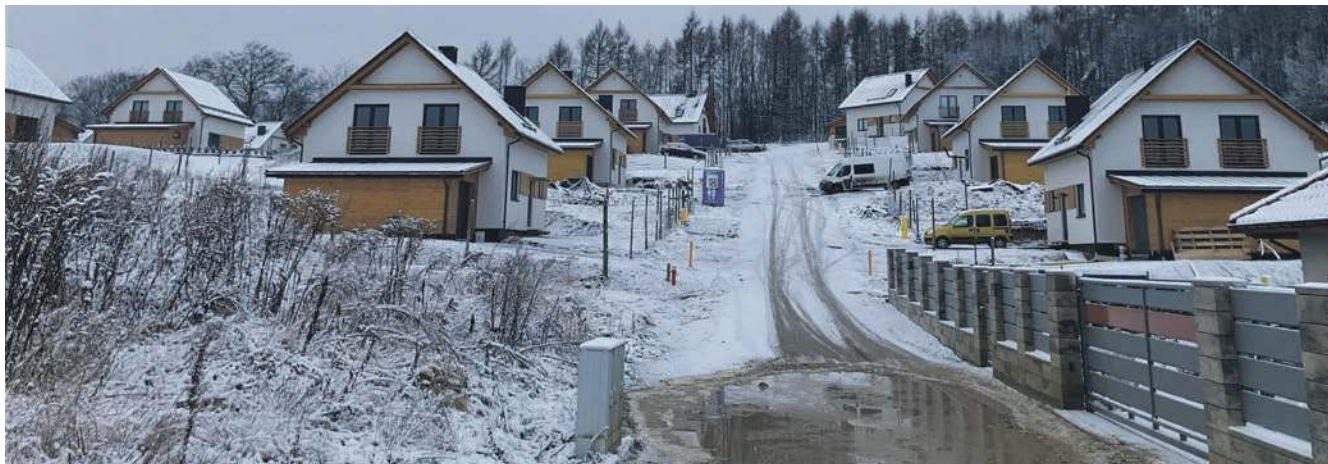
Osiedle domów jednorodzinnych przy ul. Spacerowej w Młoszowej. Pierwszy etap inwestycji został zakończony
