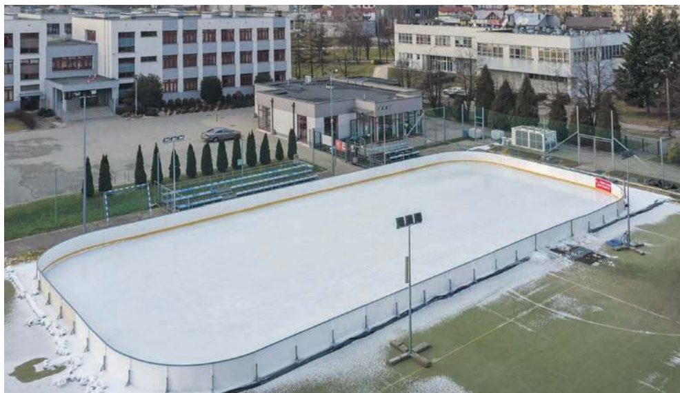
W planach jest budowa zadarszenia lodowiska oraz budowa kortu tenisowego i przebudowa boiska przy II LO i SP nr 10 w Chrzanowie
