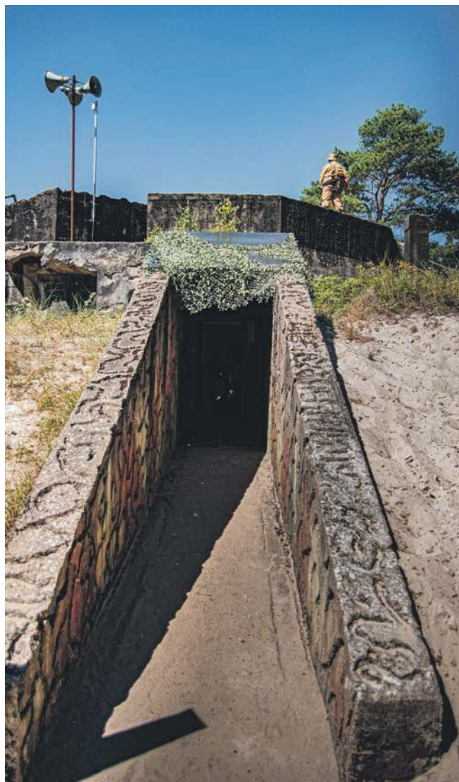
Wejście do wnętrza bunkra
