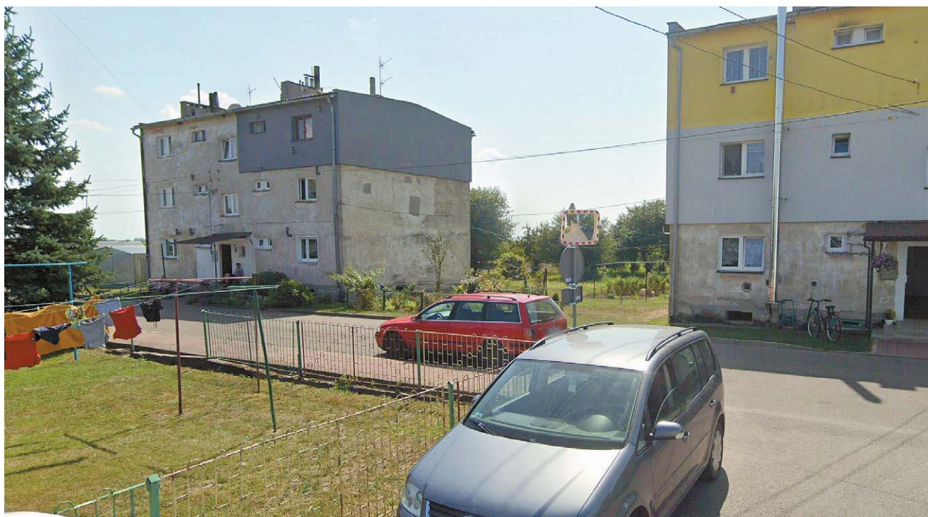
Gmina Ulhówek w powiecie tomaszowskim - jedna z najuboższych na Lubelszczyźnie. Na zdjęciu bloki w Rzeplinie budowane dla pracowników nieistniejącego już SHR-u
