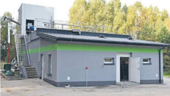
Obiekt po przebudowie. Na pierwszym planie budynek techniczno-administracyjny.
