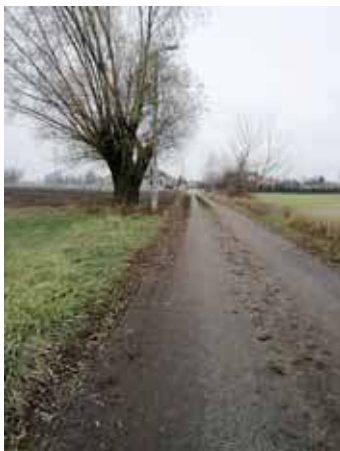
Zabrudzony odcinek drogi został uprzątnięty przez rolnika
