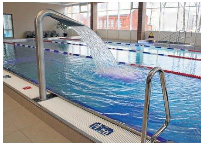
Remont basenu kosztował 4 miliony złotych. Nowa stalowa niecka basenu będzie służyć przez lata
