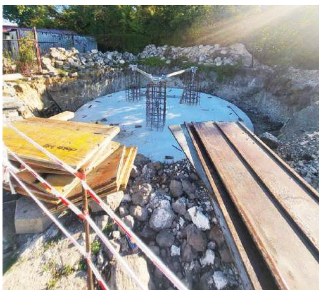
Zostały już wylane fundamenty pod nowy maszt.
