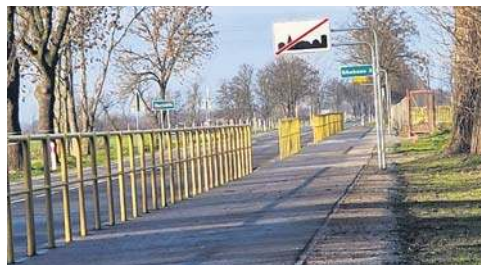
Droga dla rowerów z dopuszczeniem ruchu pieszego Piechanin–Głuchowo
