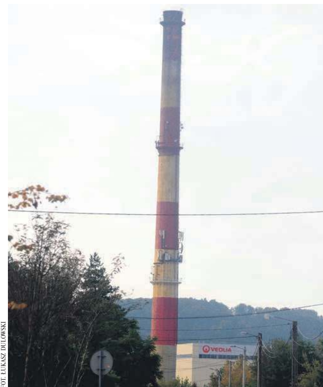
Ciepłownia Veolii Południe przy Pogorskiej w Chrzanowie
