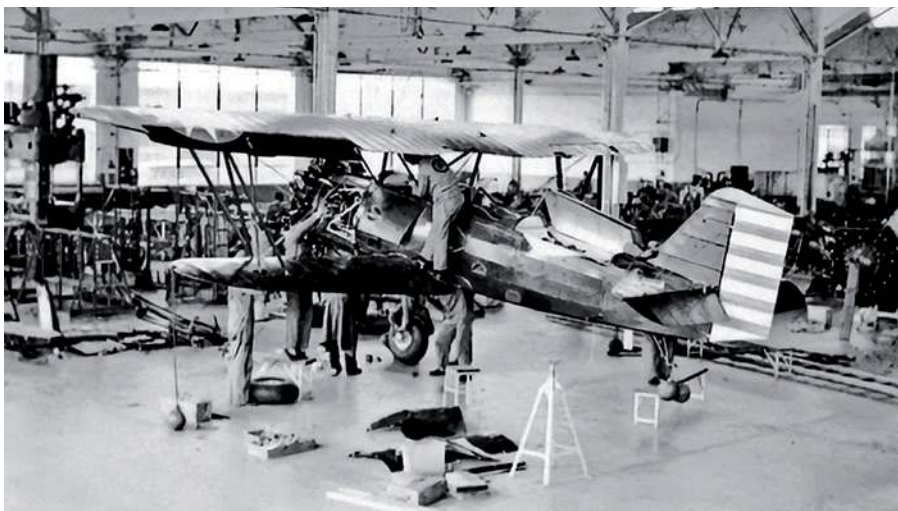
▲ W początkowym okresie działalności Central Aircraft Manufacturing Company (CAMCO) na lotnisku Jianqiao koło Hangzhou odbudowano dziesięć rozbitych myśliwców typu Curtiss Hawk II . W połowie września 1937 roku 28. Dywizjon uzbrojony w te maszyny został podzielony. Jedna grupa czterech Hawków II , wzmocniona przez trzy inne maszyny pozostałe po rozwiązaniu tymczasowym 34. Dywizjonie została wysłana na północ do Taiyuan. Pozostałe cztery (lub trzy) Hawki II skierowano na południe w celu obrony Fabryki Produkcji Samolotów w Shaoguan w prowincji Guangdong, około 200 km na północ od Kantonu.
