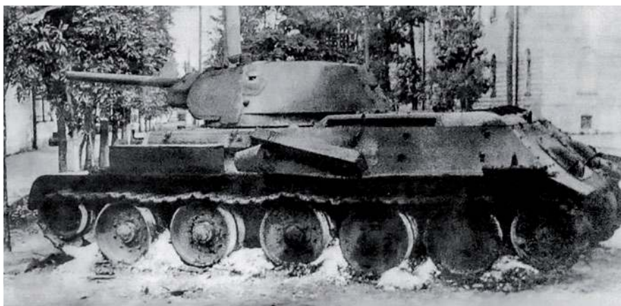
▲ Czołg średni T-34 z armatą F-34 spalony przez własną załogę w czasie walk o Wołkowysk, czerwiec 1941 roku. Pożar był dość intensywny i pochłonął całkowicie gumowe bandaże kół. Eksplozji amunicji nie było, czyli została już zużyta. Mogło dojść do awarii przy jeszcze częściowo wypełnionych zbiornikach. Pojazd wchodził w skład 11. Korpusu Zmechanizowanego.
