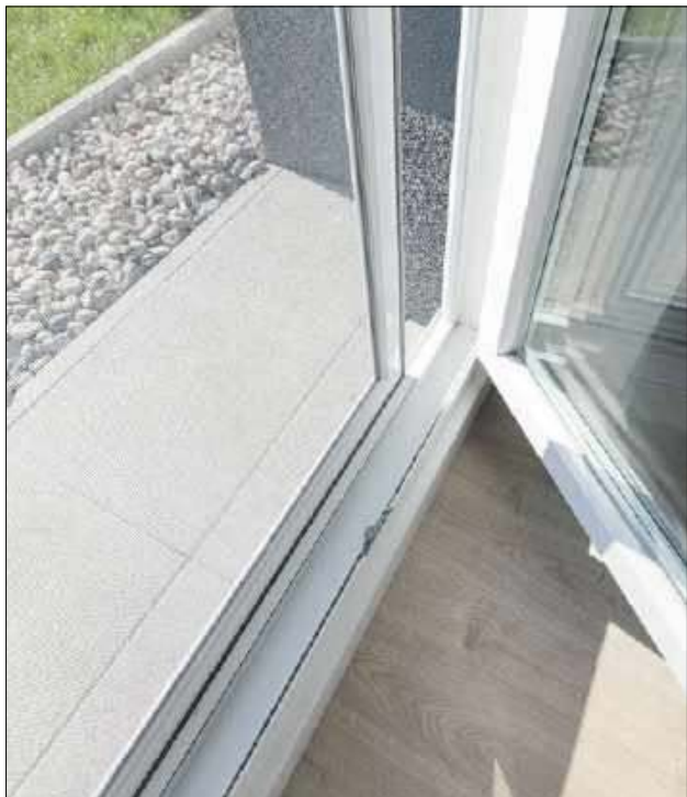
Moskitiera przesuwana przesuwa się po prowadnicach, umożliwiając swobodne przechodzenie między częścią ruchomą a stałą
