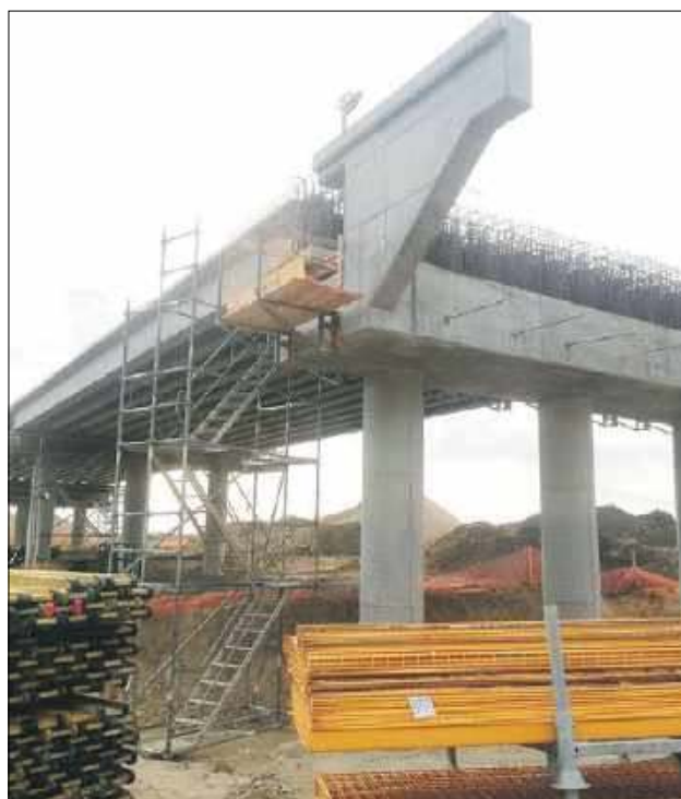
GDDKiA informuje też, że w procedowaniu są roszczenia wykonawców, którzy oczekują wydłużenia czasu na ukończenie robót lub dodatkowych środków finansowych
