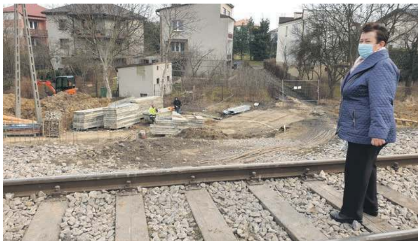
Krystyna Drewnowska, przewodnicząca os. Nowy Świat, tuż przy torach. W tle widok na roboty budowlane od strony ul. Słonecznej
