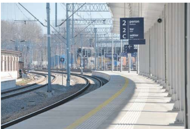
Widok na peron drugi na stacji kolejowej w Trzebini
