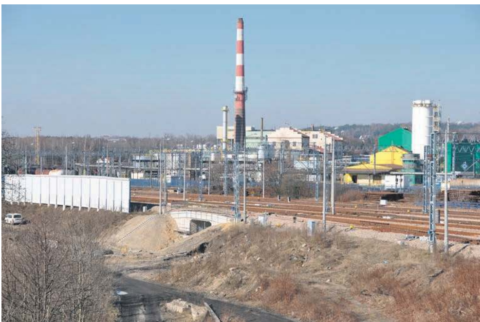
Widok na przebudowywany wiadukt nad ul. Dworcową w Trzebini
