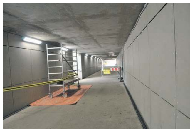
Przejście podziemne na stacji PKP w Trzebini
