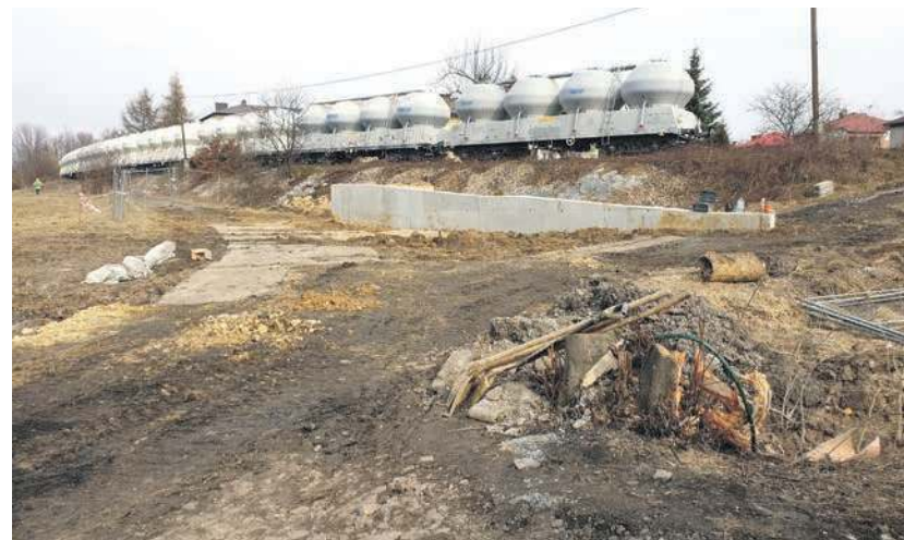
Od strony ul. Dąbrowskiego widać już fragment przejścia przez tory
