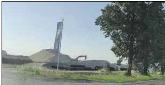
W Ciciborze Dużym powstało zaplecze pod budowę autostrady A2. W ostatnim czasie pojawiło się tam więcej sprzętu i materiałów. Czy to oznacza, że niebawem rozpocznie się budowa trasy?
