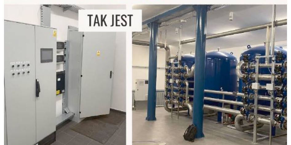
Zdjęcie przedstawia efekt po wykonanych pracach
