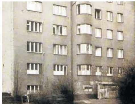
75 lat temu budynek przy ul. ks. Markwarta 4 zajmował Urząd Bezpieczeństwa
