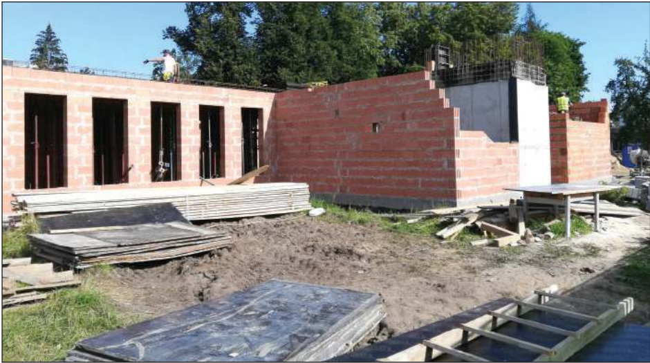
W Dęblinie trwa budowa przyszpitalnego oddziału rehabilitacyjnego. Na parterze będą m.in. sale do ćwiczeń, a na piętrze 12 łóżek dla pacjentów
