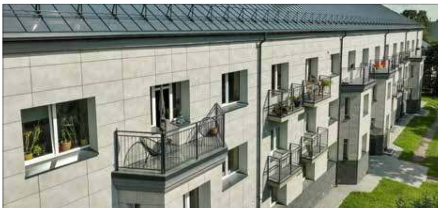
Blok wielomieszkaniowy przy ul. Trakų 31 w Kownie po renowacji Fot. z archiwum APVA
